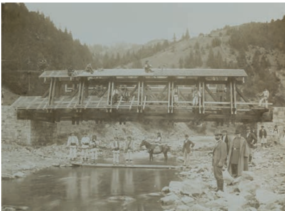
476. Pokucie. Most kratowy nad Rybnicą. Ok. 1900.
